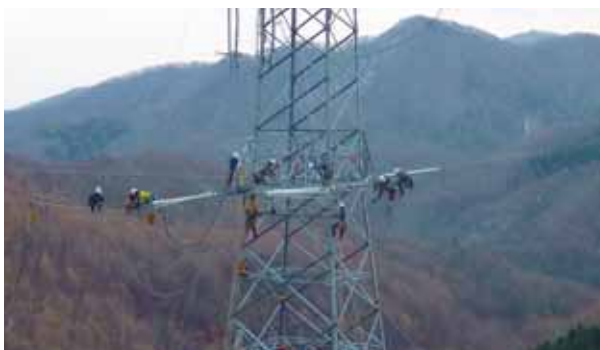
▲電線移線作業の様子
