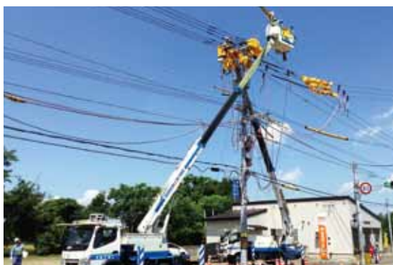
▲無停電工法による高圧電線移線作業
