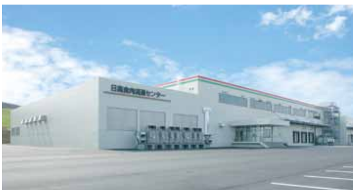
▲ 日高食肉流通センター(空調給排水衛生設備工事)
